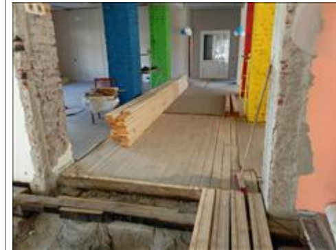
Ремонт помещения Покраска колонн центрального зала инклюзивных мастерских
