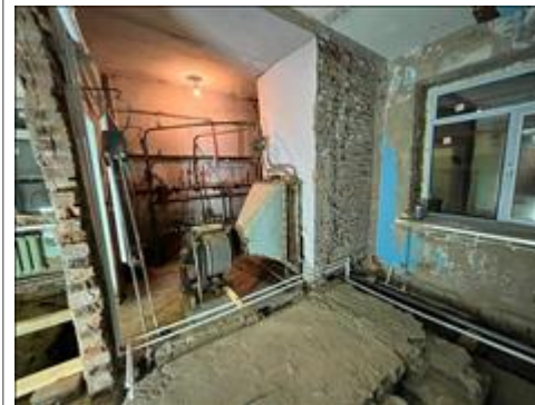
Ремонт в тепловом узле Рамка ввода помещения инклюзивных мастерских
