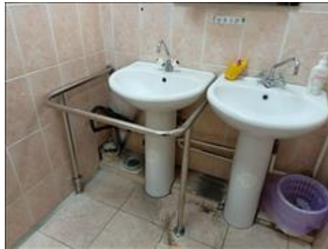
Поручень для раковины с двумя доп. опорами в пол Оборудование санузла для маломобильных граждан
