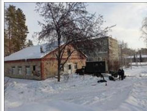
Восстановление канализации Привлечение городских служб, Управления городского хозяйства и Трансэнерго
