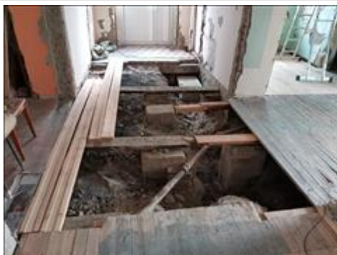
Восстановление пола Замена досок, с последующим покрытием фанерой и укладкой линолеума
