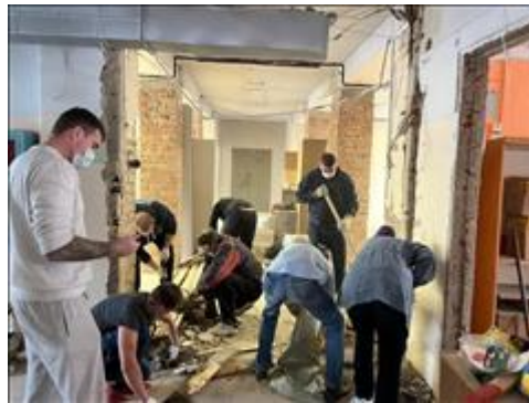
Ремонт помещения Демонтаж старых аварийных перегородок
