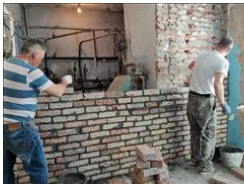
Кладка кирпичной стены Стена санузла
